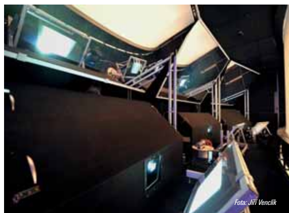
Projekční kabina v TV studiu s projektory, akustickými boxy a soustavou zrcadel.
